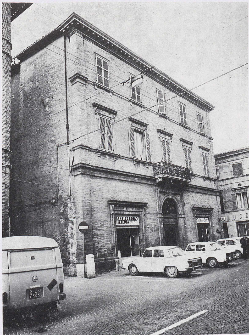
La facciata del Palazzo Tomani, in Piazza Costanzi
