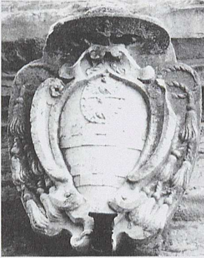
Fig. 8. Stemma del cardinale Scipione Borghese posto sopra la chiave della prima arcata, a sinistra dell'osservatore, della loggia.
