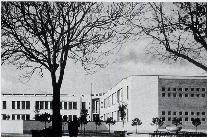
Fig. 8. Un'altra immagine della scuola e del giardino pubblico su viale Gramsci. La foto è tratta dal volume di A. Pica, Nuova architettura italiana , Quaderni della Triennale, Milano 1936, p. 305
