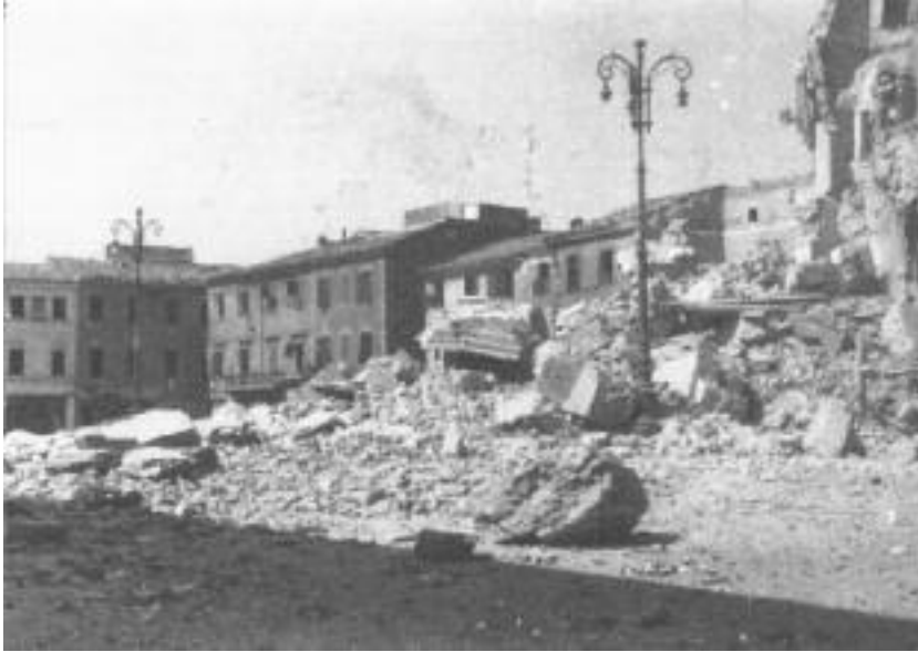
Fig. 38 - Macerie della torre civica in Piazza XX Settembre nel 1944 (Biblioteca Federiciana, Fondo Fotografico, FF1945).
