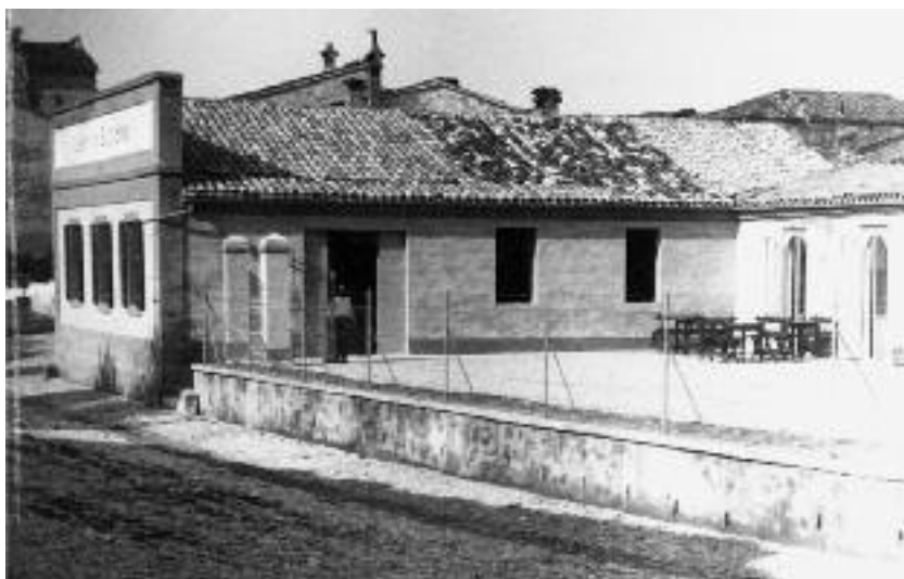
Fig. 50 - Abele Cerasoli. Casa dei socialisti nei pressi del Bastione Sangallo nel 1919 (Biblioteca Federiciana, Fondo Fotografico, Armadio E, scatola 49 i).
