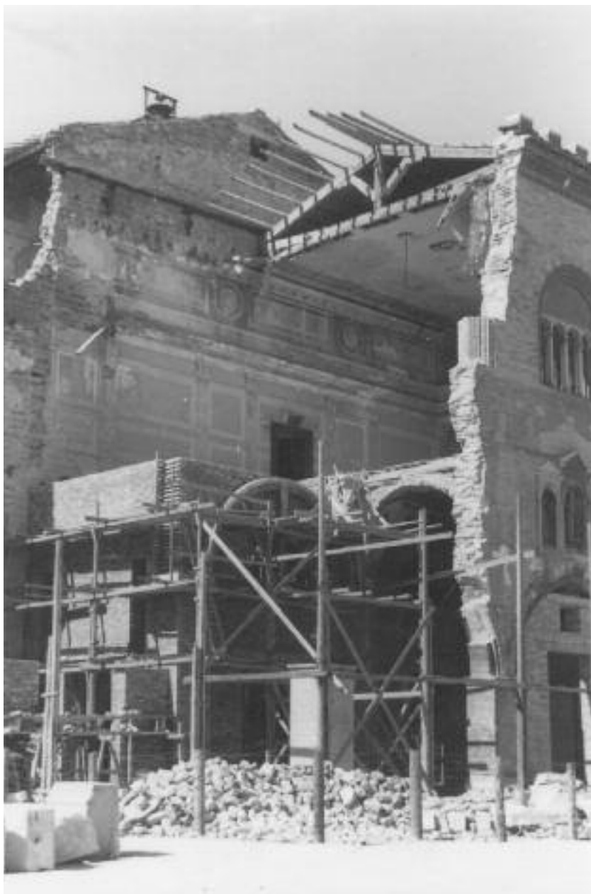
Fig. 39 - Lavori di ricostruzione della torre civica in Piazza XX Settembre (Biblioteca Federiciana, Fondo Fotografico, FF3729).
