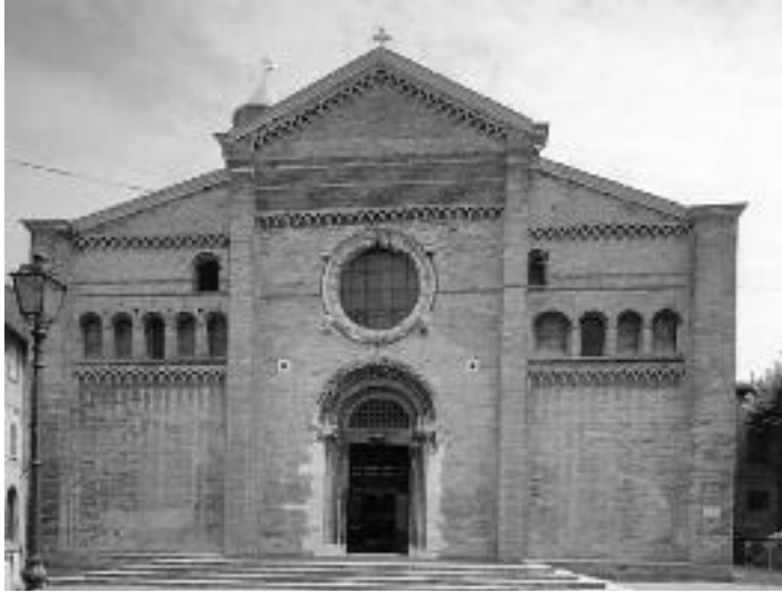
La situazione attuale della facciata.
