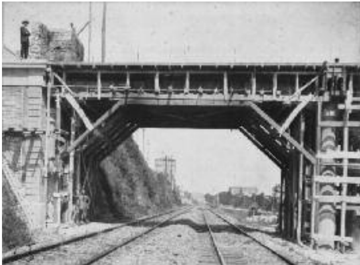
Fig. 29 - Abele Cerasoli. Costruzione del Cavalcavia Cristoforo Colombo nel 1924 da parte dell'Impresa Luigi Frasnedi di Bologna (Biblioteca Federiciana, Fondo Fotografico, Armadio E, scatola 45 f).
