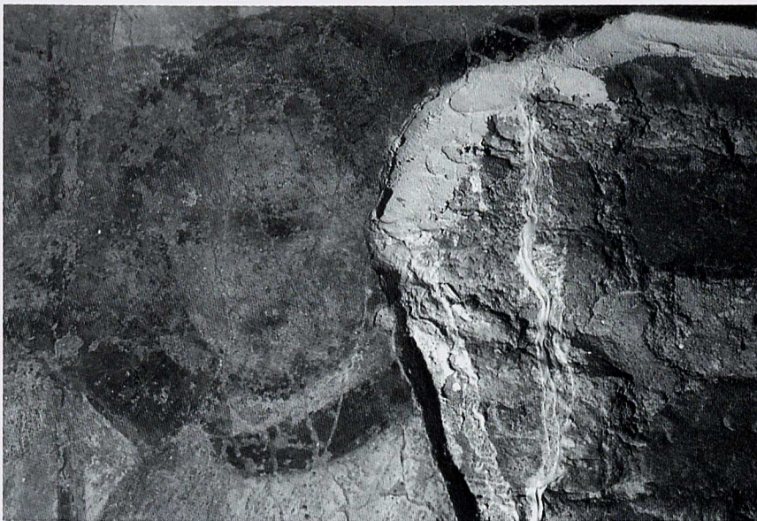
Iniezione di malta idraulica (resina acrilica) per il consolidamento (lunetta n. 3)
