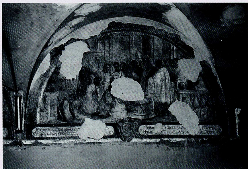
id., dopo il restauro.
