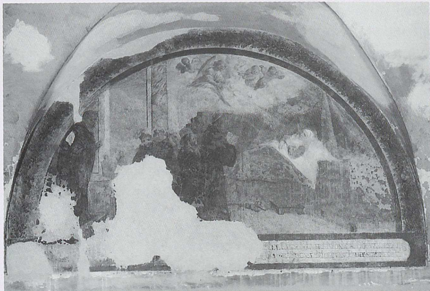
id., dopo il restauro.
